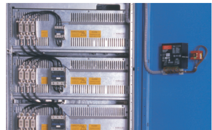
KUVA: Kennokojeistoon voidaan integroida Norelco NACB-kompensointijärjestelmä, jolloin työmaalla ei tarvitse tehdä erillisten kaappien välistä johdostusta
