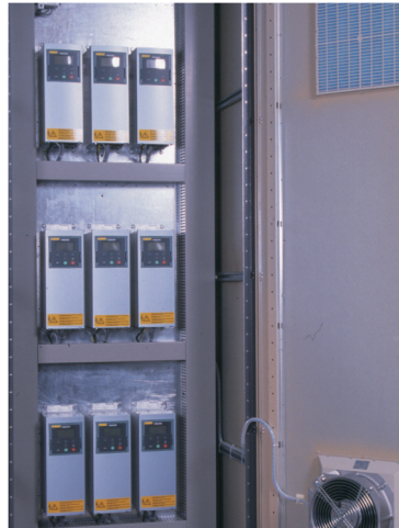
KUVA: invertterilähtöjä
