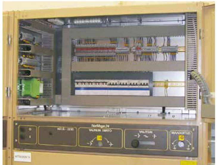
Toisiotilojen väliset kytkennät tehdään ohjauspistokkeilla
