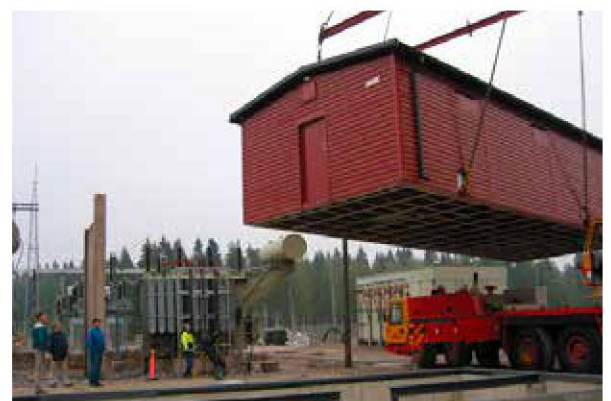
NorSwitch-sähköasemarakennus voidaan toimittaa valmiiksi kalustettuna työmaalle
