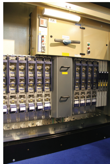
KUVA: Pienjännitekojeistossa käytetään laadukkaita eurooppalaisia jonovarokeytkimiä, joita voi olla enintään 12 kappaletta.
