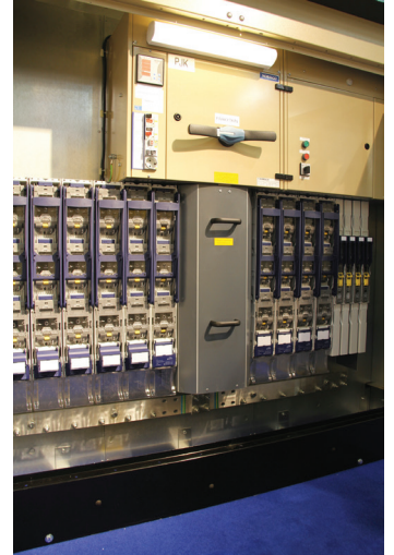
KUVA: Pienjännitekojeistossa käytetään laadukkaita eurooppalaisia jonovarokeykykimiä, joita voi olla enintään 12 kappaletta.
