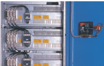
KUVA: Kennokojeistoon voidaan integroida Norelco NACB kompensointijärjestelmä, jolloin työmaalla ei tarvitse tehdä erillisten kaappien välistä johdostusta
