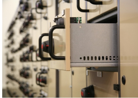
KUVA: Kasetti vedetään ulos liukukiskoja pitkin erotusasentoon, josta se saadaan irti vapautusvivun avulla
