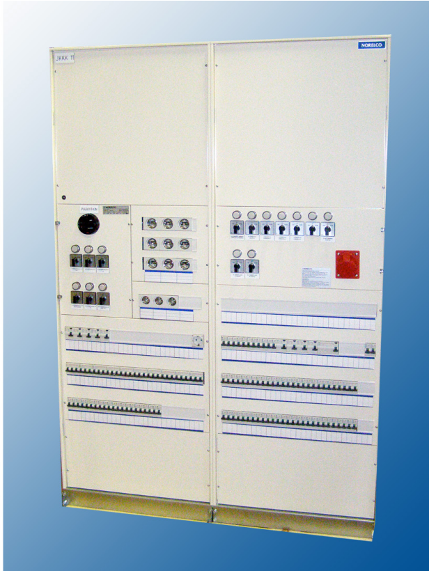
NorLine keskukseseen voidaan kalustaa katkaisijoita, sulakkeita, ohjauskojeita, pistorasioita, releitä ja muita kojeita
