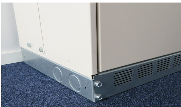
KUVA: Sokkeli on osa hyvin suunniteltua ilmankiertojärjestelmää, ja se on edestä avattava. Läpivientiaihiot mahdollistavat keskuksen jatkamisen.
