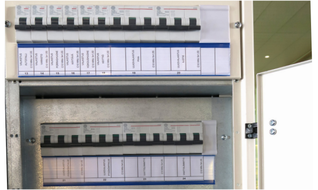
KUVA: DIN-komponentit voidaan sijoittaa tilassa joko oven alle tai kanteen DIN-aukkoasennuksena
